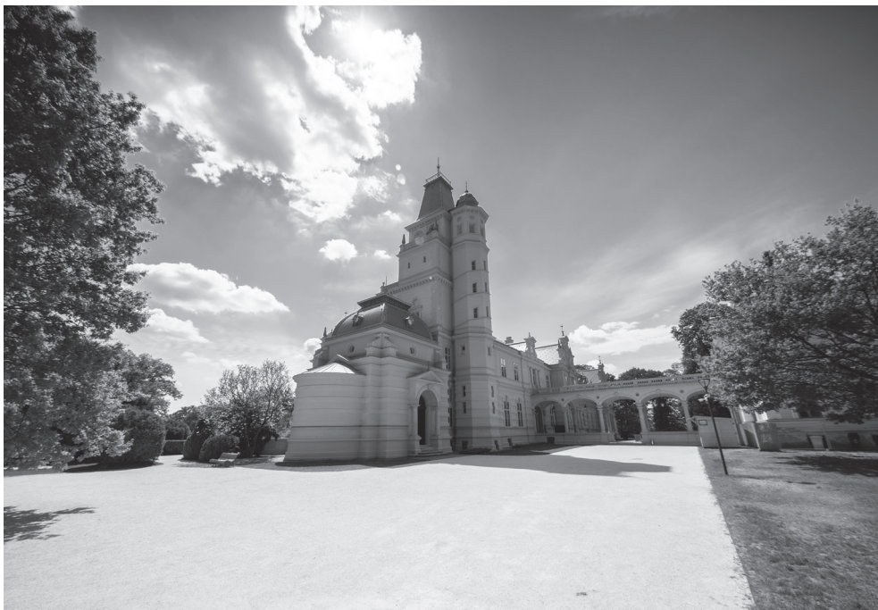
A kastély épülete a kápolna felől
