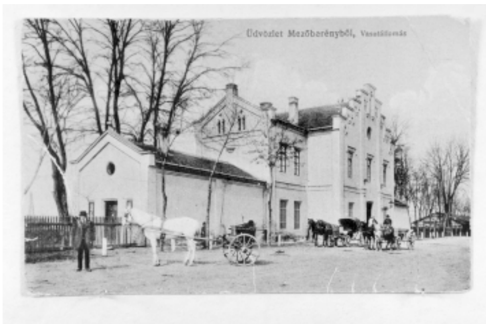
A vasút kapcsolta először szorosan Békést az ország centrumához – Mezőberény
